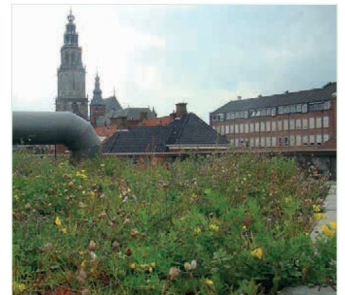
Dak Werkmancollege Groningen: Mengsel D2
